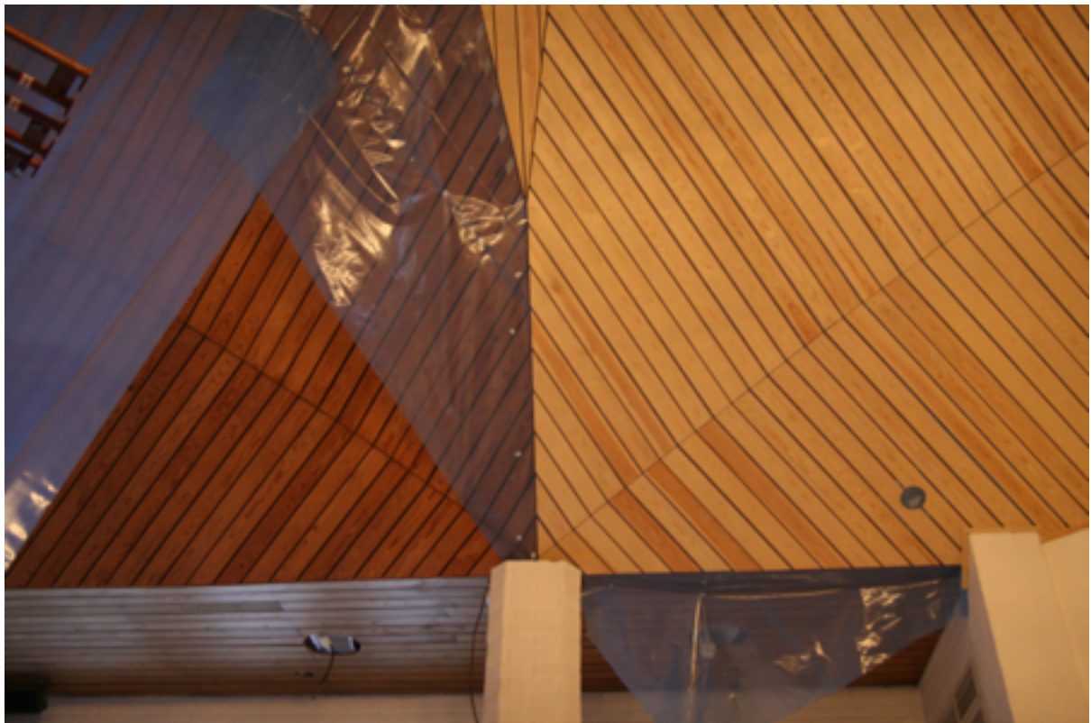
Baugerüst und alt/neu nebeneinander samt der sichtbaren Dampfsperre = Folie
