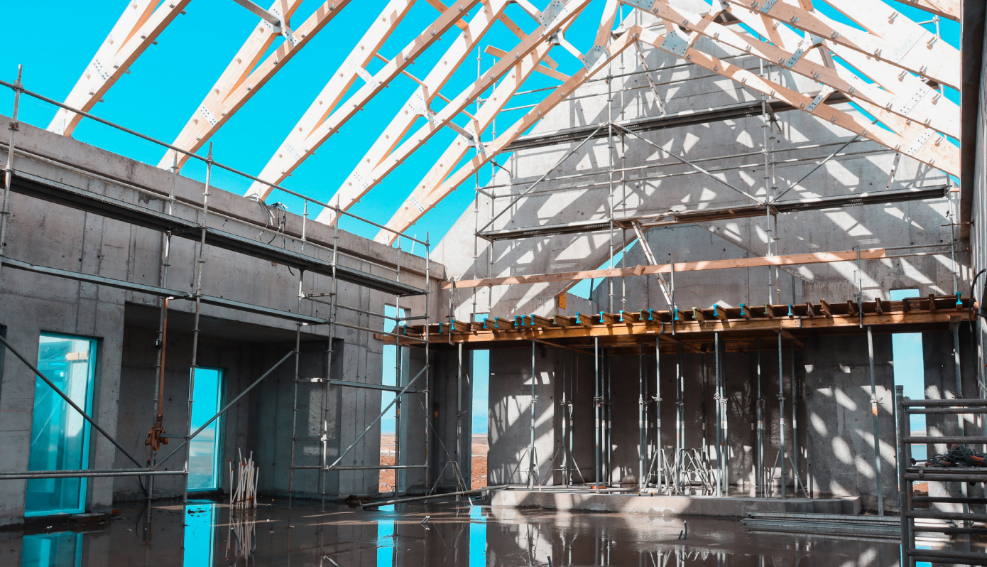
// OBEN: Baufortschritt auf Island, wo für die wachsende Gemeinde in Selfoss eine neue Kirche entsteht
