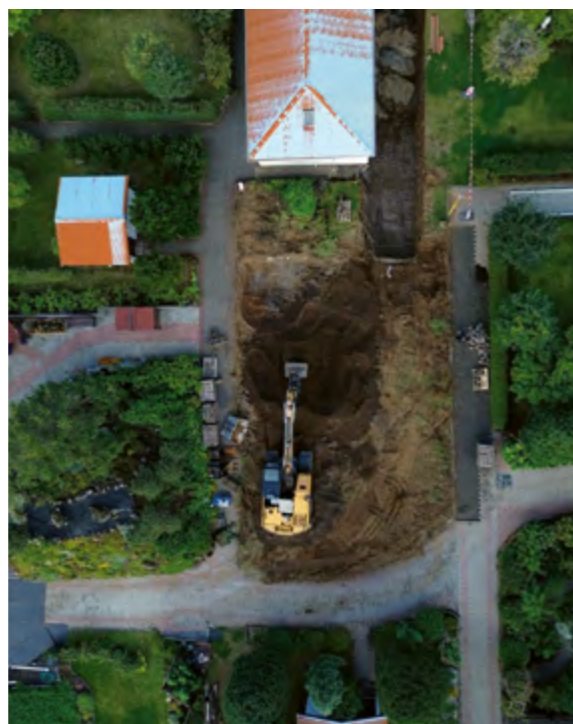
↓ Die Baustelle aus der Vogelperspektive
